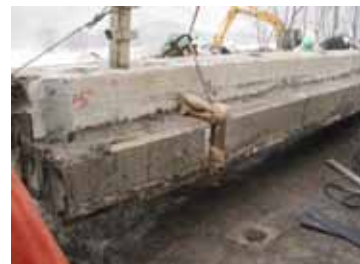
板ジャッキを使用したPC橋解体
