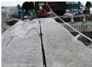
板ジャッキを使用したPC橋解体
